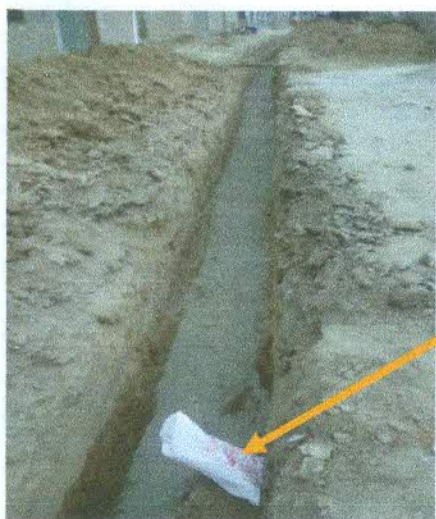
TERRENO COMPACTADO 480 m, LINEA DE IMPULSION DE 200mm Ø
