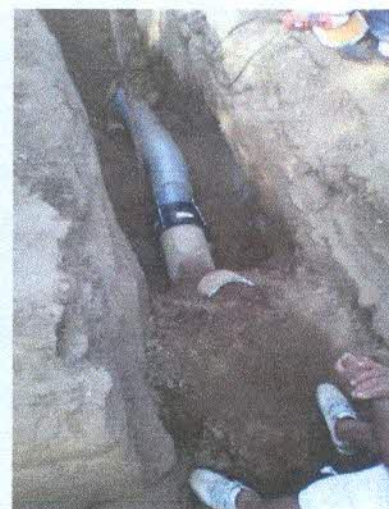
TERRENO COMPACTADO 480 m, LINEA DE IMPULSION DE 200mm Ø
