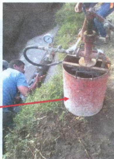
BOMBA DE AGUA MANUAL UTILIZADA EN PRUEBA HIDROSTATICA DE NUEVA MATRIZ, EX - PUNTE VENENO EN SECTOR PRIMAVERA
